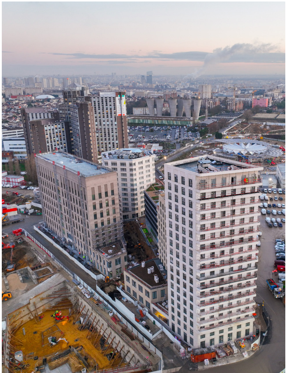
Photographie : Bouygues Immobilier
